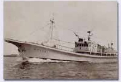
2代みやざき丸 鋼製 219.65t S34.5.20竣工 ディーゼル650馬力 11.25ノット
