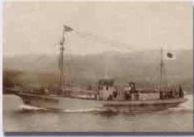
日向丸 鋼製帆船 69.89t S23.31.竣工 ディーゼル 130馬力 8.6ノット
